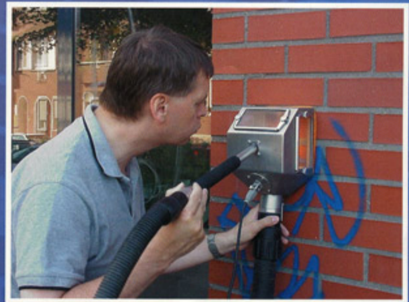
Reinigungsarbeiten an einer Klinkerwand
